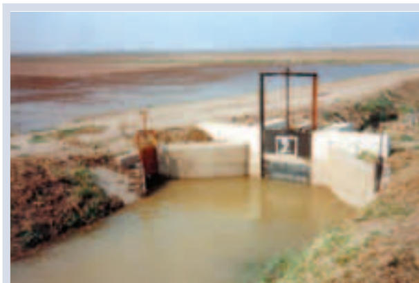
Figura 5.20. Canal de riego con compuerta repartidora.
