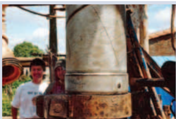
Figura 2.19. Instalación de tubería.
