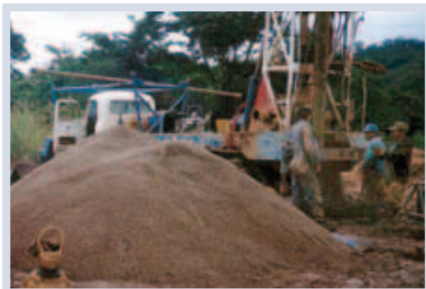
Figura 2.20. Instalación de grava en pozos.
