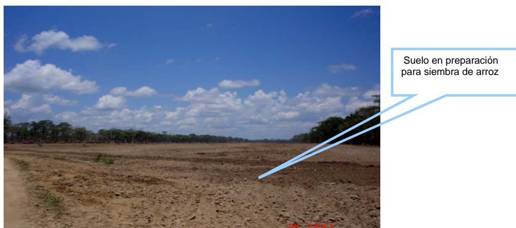
Figura 5.7.2 Desmante Mecanizado realizado por Empresarios
